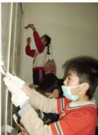
重新粉刷老牆壁
